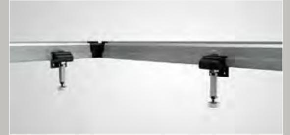
... in die Fußklauen eingeschraubt und anschließend vorjustiert. Ihre Konstruktion erlaubt eine Feinjustierung nach Einbringen des Estrichs.
