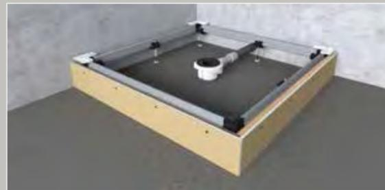
Im Anschluss wird das System ausgerichtet und die Schalungspaneele befestigt. Dann wird der Estrich eingebracht.
